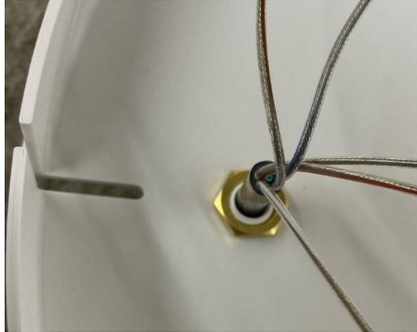
7. Leuchtzuleitung an der Deckenplatte des Deckenbaldachines anschließen, dabei auf die Codierung der Einzeladern achten!
