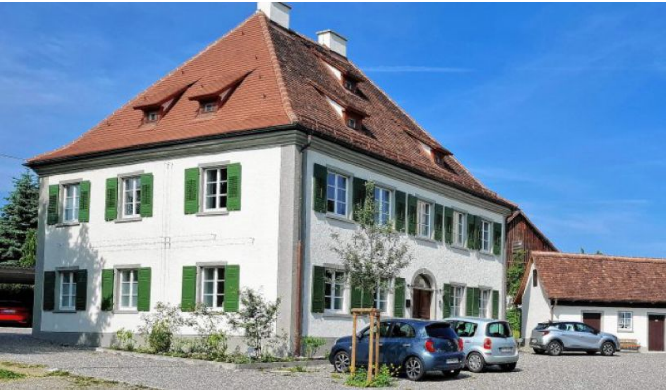
Das Pfarrhaus in Urnau aus dem Jahr 1794 ist von Grund auf saniert und mit klimafreundlicher Technik ausgestattet worden. Das Projekt hat den Innovationspreis „Denkmal – Energie – Zukunft“ erhalten. FOTOS: WOLF-DIETER GUIP
